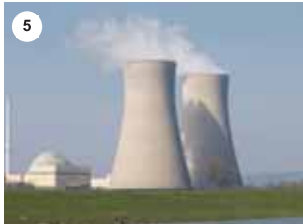
Elektrik stansiyalarının inşası
