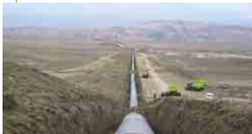
Водопровод Огуз–Габала– Баку
