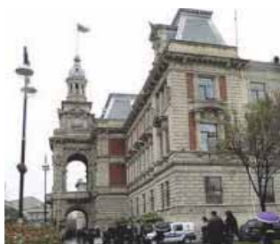
Здание Бакинской мэрии
