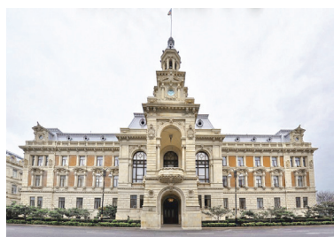
Здание Бакинской Городской Думы (современный вид)
