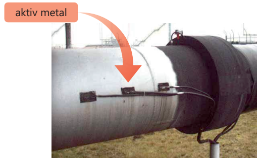
Aktiv metal polad borunu korroziyadan qoruyur
