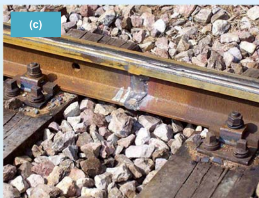
(b) – Alüminotermiya üsulu ilə relslərin qaynaq edilməsi; (c) – qaynaq edilmiş rels.
