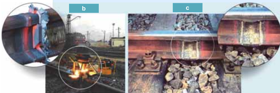
(b) – Alüminotermiya üsulu ilə relslərin qaynaq edilməsi; (c) – qaynaq edilmiş rels.
