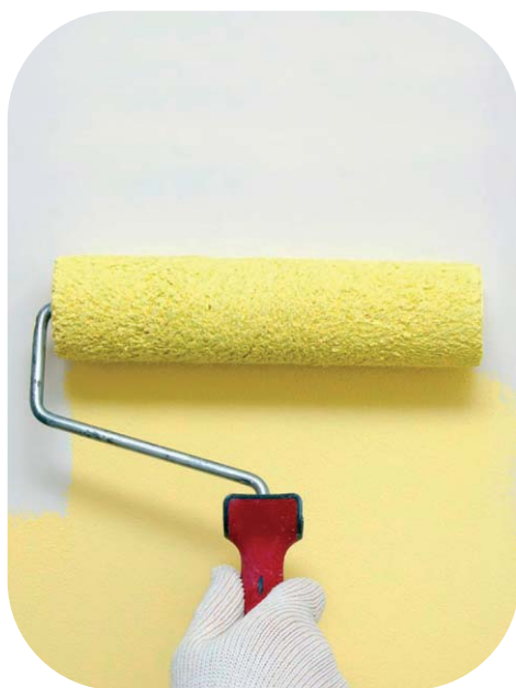
Рис. 2. Окрашивание поверхности изделий губчатым валиком
