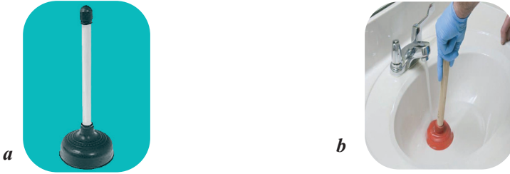
Şəkil 6. Sifonun vantuzla mexaniki təmizlənməsi: a – vantuz; b – sifonun vantuzla təmizlənməsi
