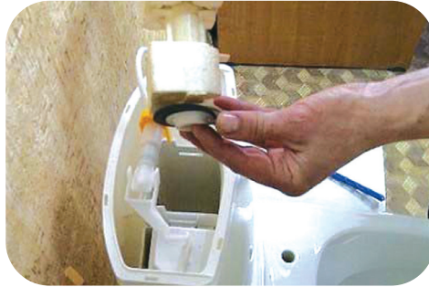
Şəkil 4. Pərdənin yenisi ilə əvəzlənməsi
