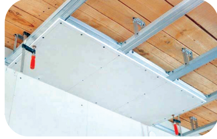
Şəkil 8. Gipskarton lövhələrin bərkidilməsi
