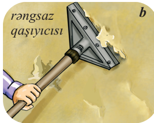
Şəkil 1. Rəngin çıxarılma üsulları: a, b – mexaniki, c – termik
