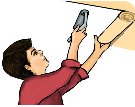
Şəkil 2. Tavana divar kağızının çəkilməsi
