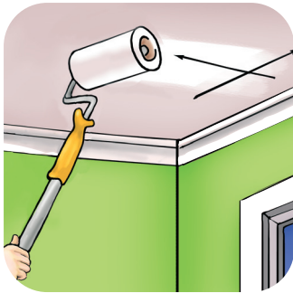
Şəkil 1. Tavanın rənglənməsi
