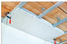
Şəkil 8. Gipskarton lövhələrin bərkidilməsi
