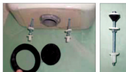
Şəkil 3. Boltların dəyişdirilməsi
