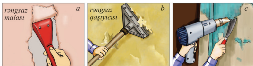
Şəkil 1. Rəngin çıxarılma üsulları: a, b – mexaniki, c – termik
