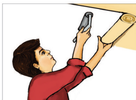
Şəkil 2. Tavana divar kağızının çəkilməsi
