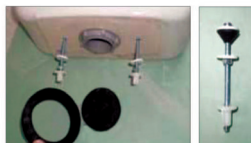
Şəkil 3. Boltların dəyişdirilməsi
