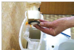
Şəkil 4. Pordənin yenisi ilə əvəzlənməsi
