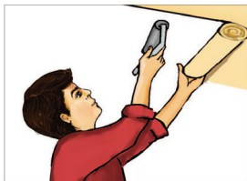
Şəkil 2. Tavana divar kağızının çəkilməsi
