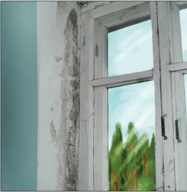
Şəkil 1. Köhnəlmiş pəncərə çərçivəsi
