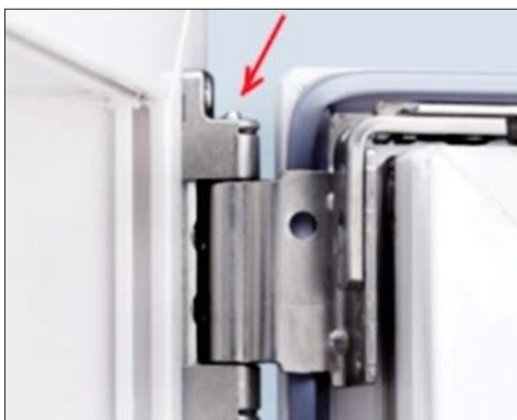
Şəkil 4. Həncamadan oxun çıxarılması
