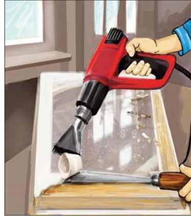
Şəkil 2. Köhnəlmiş boyanın inşaat feni ilə çıxarılması
