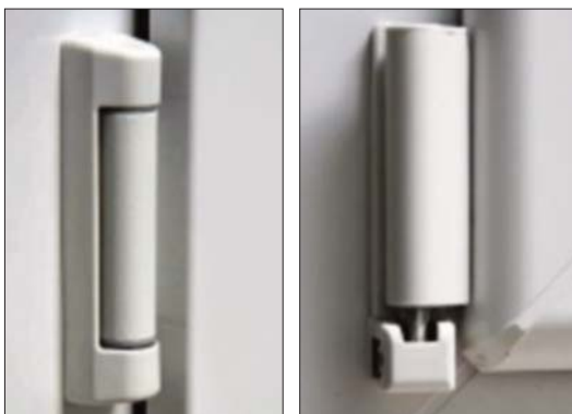
Şəkil 3. Həncamalardan dekorativ qapağın çıxarılması
