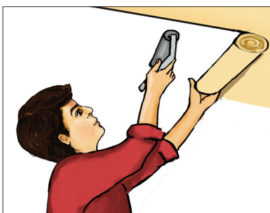
Рис. 2. Наклеивание обоев на потолок
