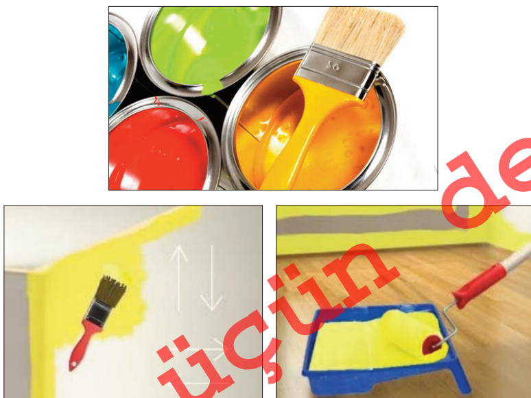
Рис. 3. Последовательность окрашивания стены
