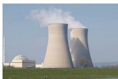
Elektrik stansiyalarının inşası
